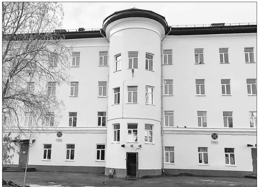
■ В центре инфекционных болезней областной больницы в этом году выполнен большой ремонт. ФОТО ПРЕДОСТАВЛЕНО ПРЕСС-СЛУЖБОЙ МИНЗДРАВА АРХАНГЕЛЬСКОЙ ОБЛАСТИ
